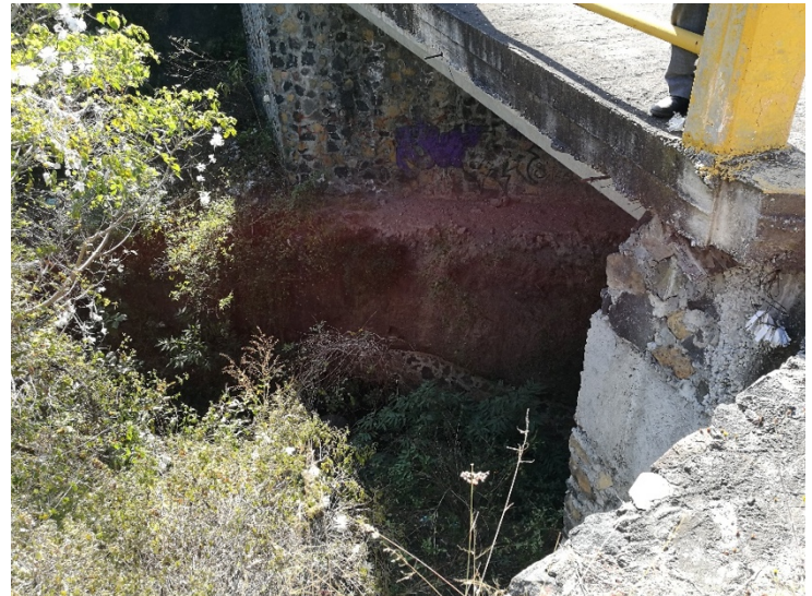
Figura 62. Las rocas que afloran a lo largo de la zona de estudio son rocas y depósitos volcánosedimentarios, los últimos tiene la desventaja de ser poco resistentes a las erosión. Los Limones.
