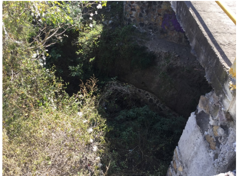
Figura 51. Detalle de la ladera de un drenaje en la que se ha tenido que colocar mamposteo para evitar que continuara la erosión y se pudiera generar un derrumbe que dañara el puente. Localidad Los Limones
